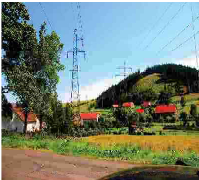
Rys. 1. Rysunek ukazujący dwie linie 110kV w okolicach Wałbrzycha
