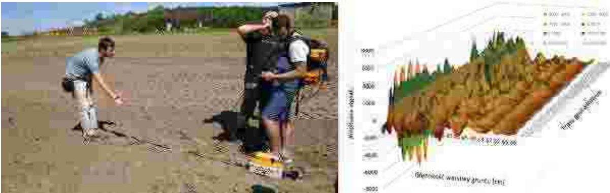
Rys. 1. Pomiar geodarem stopnia ugniecenia gruntu oraz przykładowa charakterystyka amplitudy sygnału
