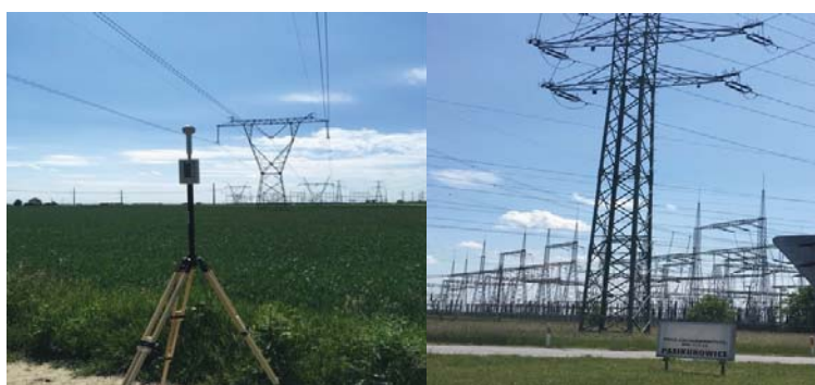
Rys. 1. Miejsce przeprowadzenia badań terenowych obok stacji elektroenergetycznej w Pasikowicach, woj. dolnośląskie
